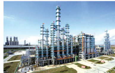
sistema de control industrial
