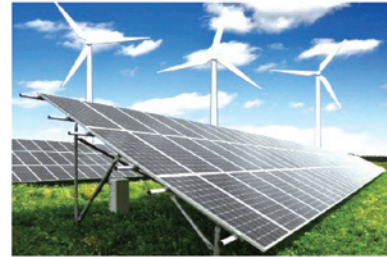
sistema de energía solar
