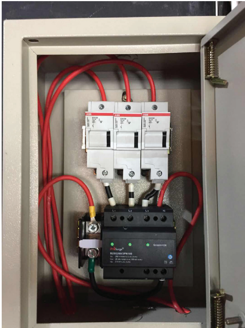
protector contra sobretensiones para el cuadro de distribución principal y el cuadro de distribución secundaria
